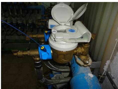
Figura 20. Ejemplo de un contador de telelectura instalado, con el precinto anti-fraude/manipulación (izq.). Batería de contadores de telelectura en bloque de pisos (dch.)
