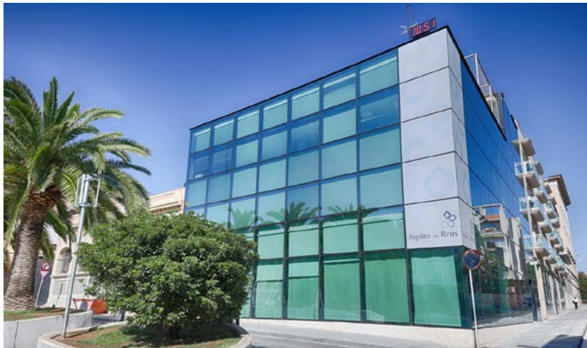
Figura 5. Oficinas centrales Aigües de Reus
