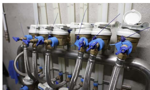
Figura 20. Ejemplo de un contador de telelectura instalado, con el precinto anti-fraude/manipulación (izq.). Batería de contadores de telelectura en bloque de pisos (dch.)
