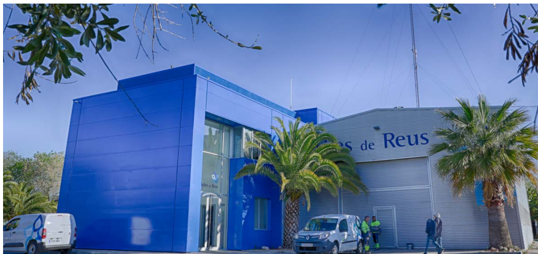
Figura 8. Nave de explotación
