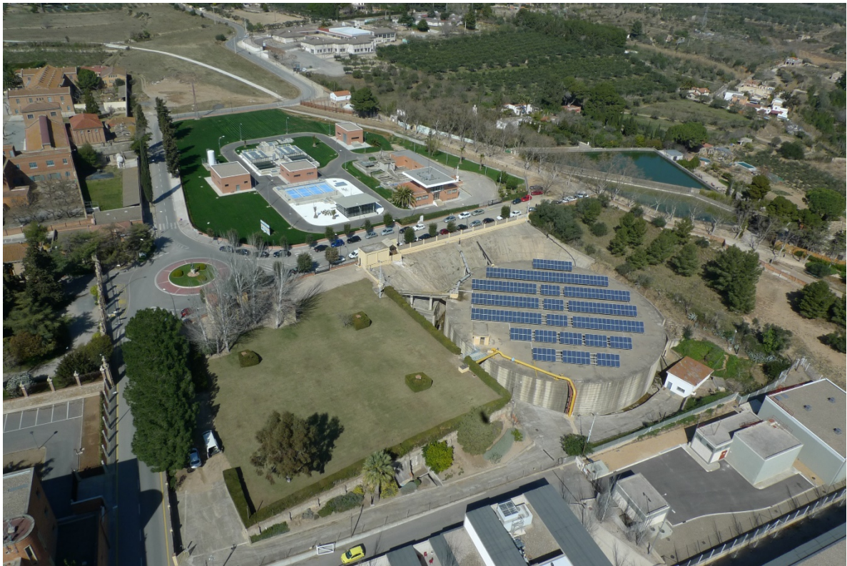
Figura 14. Vista aérea ETAP de Reus y de los depósitos abastecimiento, uno circular visto de 20.000 m3 y otro rectangular enterrado de 12.000 m3.
