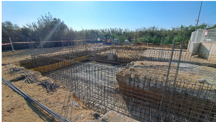
Figura 19. Estado de las obras de los pozos Bellisens, con previsión de finalización y puesta en marcha el 1er semestre del 2024
