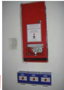
Sistema de paro de emergencia de conductas de humo.
